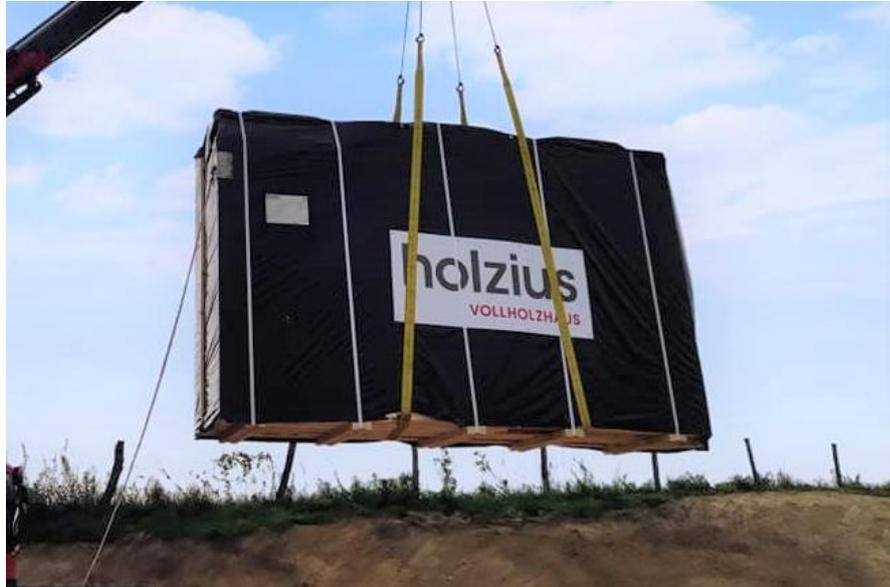
*Figura 4: Il pacco delle pareti viene sollevato con cinghie di sollevamento e collocato nella posizione di stoccaggio designata.*
