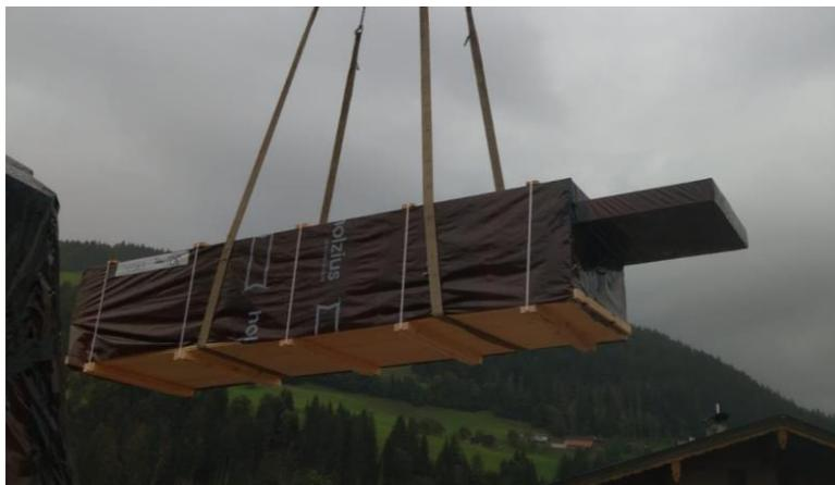
Figura 10: Il pacco con i solai in legno massello viene sollevato con cinghie sufficientemente forti e posizionato sul sito di stoccaggio.
