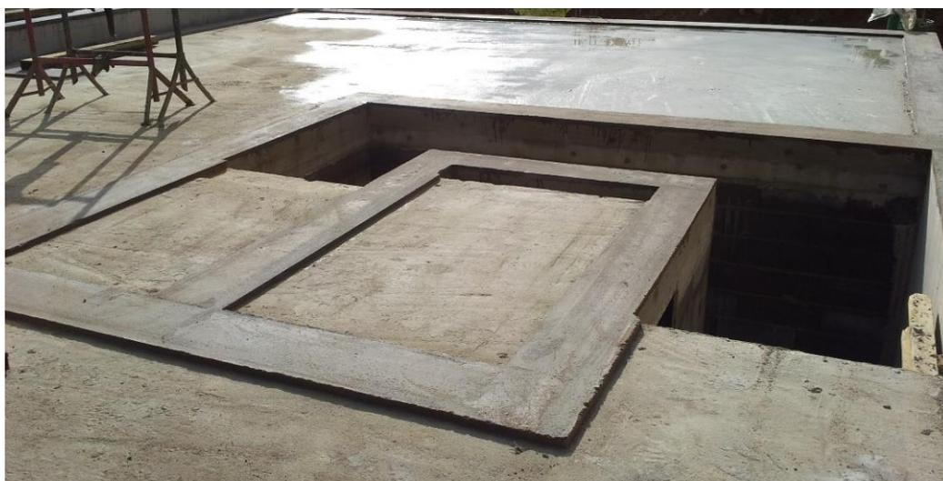
Figura 12: Prima di installare gli elementi della parete holzius, viene creato uno strato di livellamento.
