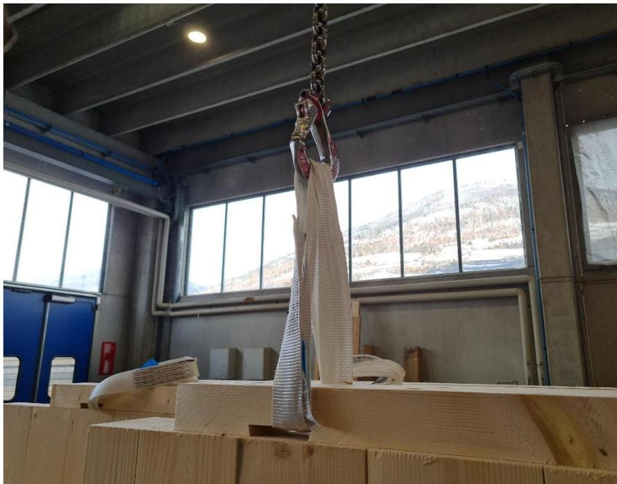
*Figura 5: Le travi di trasporto sono fissate agli elementi della parete, sui quali sono infilate le fascette usa e getta.*
