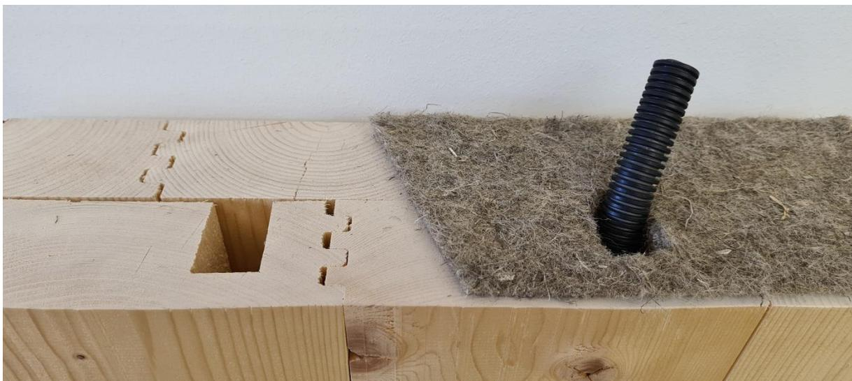
Figura 17: L'apertura nella striscia isolante di canapa permette all'elettricista di far passare i tubi.
