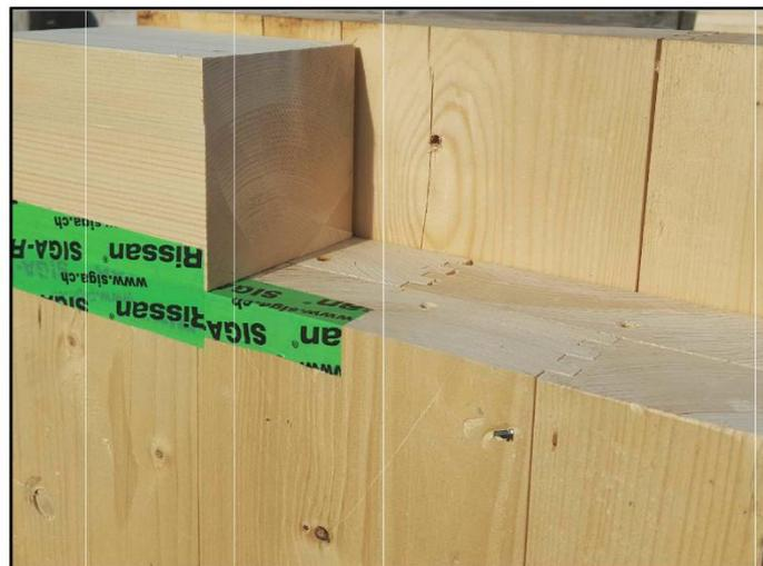
Figura 18: Collegamento a tenuta all'aria, attraverso i componenti dell'edificio e senza strisce di canapa.
