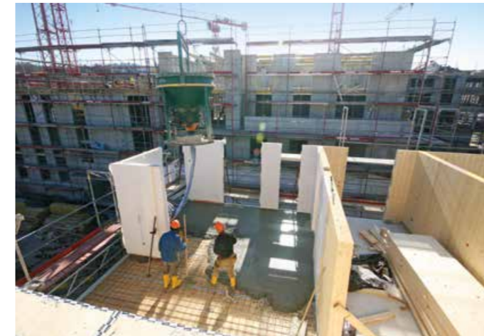
▲ Beim Verguss des Ortbetons wurden die Wandelemente abgedeckt
