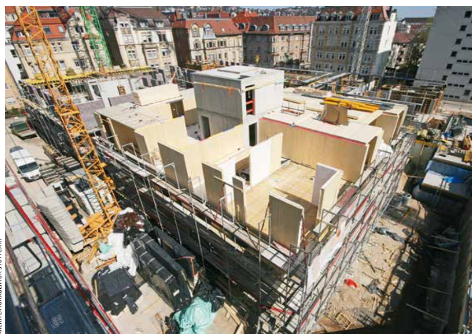
◀ Die Massivholzelemente wurden rund um den Stahlbeton-Erschließungskern gruppiert
