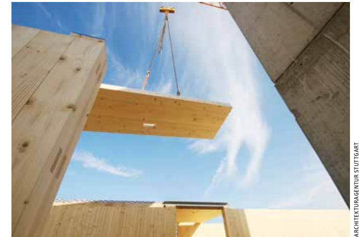
▲ Schnelle Montage dank millimetergenauer Vorfertigung
