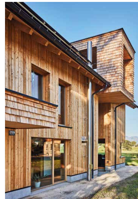
◀ Die hinterlüftete Fassade kombiniert naturbelassene Lärchenholzschindeln mit einer sägerauen Lärchenholzschalung
