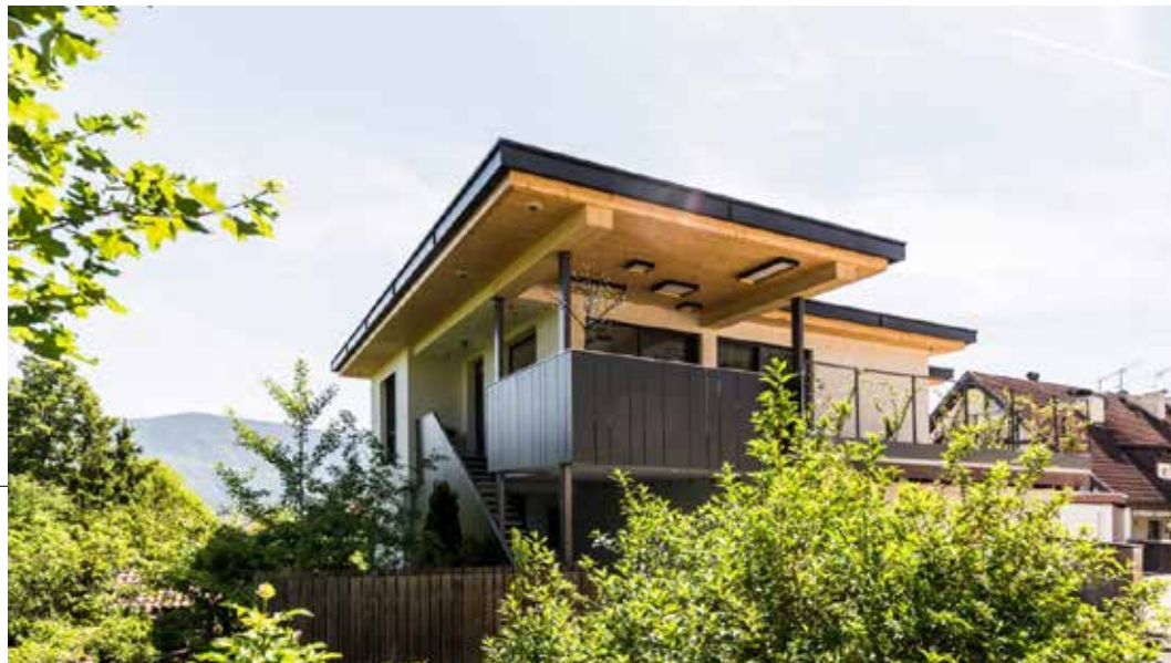
Geringes Gewicht und doch massiv: Aufstockung des bestehenden Gebäudes in Massivholzbauweise holzius
