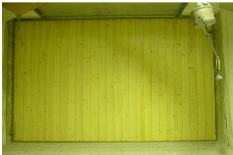
Bild 1 Foto des eingebauten Elementes vom Senderaum, erstellt vom ift Schallschutzzentrum
